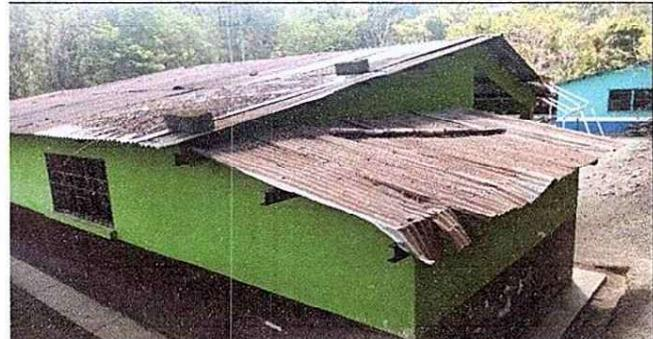
Foto 6: CAMBIO DE CUBIERTA DE LAMINA MODULO 1Y 2
