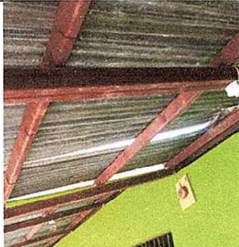
Foto 3: CAMBIO DE ESTRUCTURA METALICA MODULO 1 Y 2
